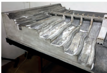
04 Model v průběhu restaurování – detailní pohled. Lokální opravy modelace ploch odtokových kanálů. Foto: Michal Polák.
