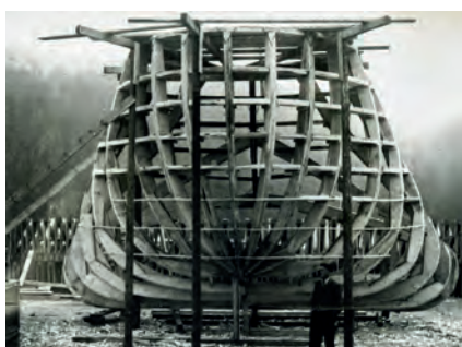
08 Konstrukce pro bednění savky (potrubí odtoku vody z turbíny). Zdroj: soukromý archiv Filipa Horkého.
