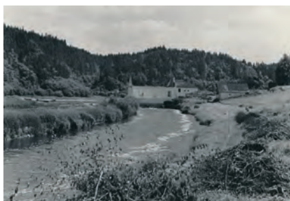
07 Odtoková strouha pod elektrárnou Rejzíkovo. Objekt již částečně demolovaný. Foto: Josef Dostál (cca 1960). Archiv Městského muzea v Týně nad Vltavou.
