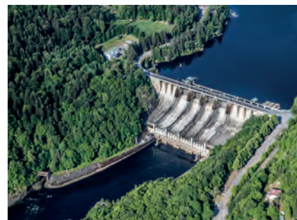
11 Letecký pohled na vzdušný líc hráze. Pod korunou hráze jsou patrné čtyři koronové bezpečnostní přelivy hrazené segmenty o rozměrech 15×8 m s odvodem vody přes objekt přelávané vodní elektrárny do vývaru. Na levé a pravé straně jsou do vývaru vyústěny dvě spodní výpusti o průměru 4 m s Johnsonovými uzávěry. Vlevo dole je do koryta řeky zaústěna obtoková štola sloužící pro převedení vody za stavby. Budova na pravém břehu je provozní objekt správce přehrady. Foto: Jiří Jiroušek, www.nebeske.cz.
