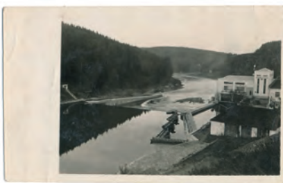
057 Nový Mlýn – elektrárna / autor neznámý / 30. léta 20. stol. / archiv Zdeňka Hamra
