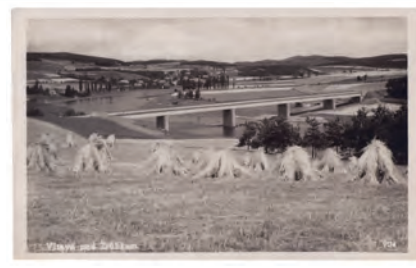
089 Vestec – nový most / nákladem J. Příhoda / konec 30. let / archiv Vojtěcha Pavelčíka
