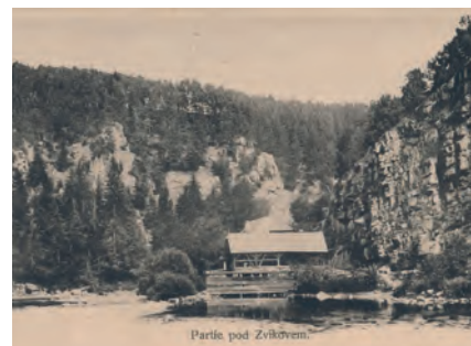
09 Jednou z významných staveb podhradí byl i mlýn u přivozu přes Otavu. Pohlednice z počátku 20. století. Archiv Vojtěcha Pavelčíka.
