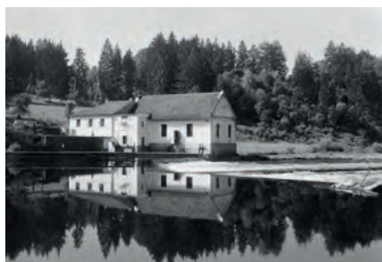
06 Areál elektrárny Rejzíkovo při pohledu z pravého břehu Vltavy v září 1959. Archiv Masarykův ústav a Archiv AV ČR, v. v. i.
