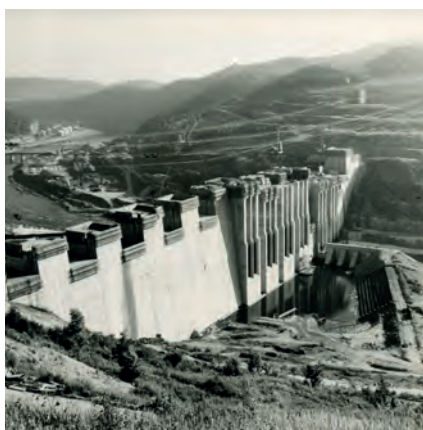
08 Návodní strana ještě nedokončené hráze, vpravo patrná stavební jámka pro bloky s vodní elektrárnou. Zdroj: Archiv katedry hydrotechniky, FSv, ČVUT v Praze.
