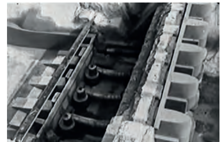
11 Pohled na vnitřní uspořádání modelu vodního díla Slapy. Celkový model hráze včetně potrubí s turbinami a spodními výpustěmi. (Výzkumný ústav vodohospodářský T. G. Masaryka, Kronika Slapské přehrady, 1950).
