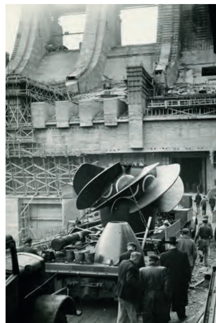
12 Oběžné kolo Kaplanovy turbíny před osazením, v pozadí okna koronového přelivu se skluzem a rozražeči. Zdroj: soukromý archiv Filipa Horkého.
