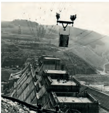
04 Betonáž hrázových bloků a systém kabelových jeřábů. Zdroj: Archiv katedry hydrotechniky, FSv, ČVUT v Praze.
