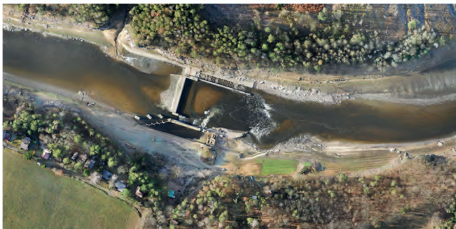
01 Letecký snímek obnaženého jezu na Novém mlýně. Stav z 11. 12. 2019, Laboratoř fotogrammetrie, ČVUT v Praze, Fakulta stavební.
