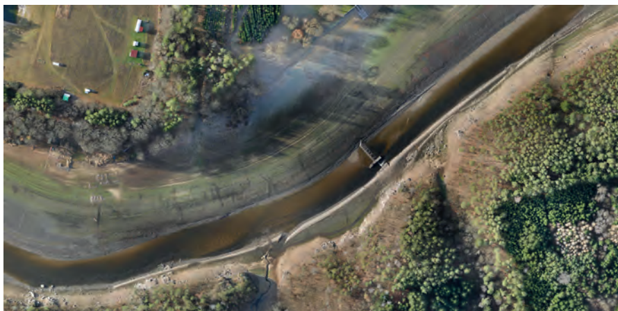
03 Letecký snímek obnaženého údolí se zbytky jezu a vorové propusti u elektrárny Rejzíkovo. Stav z 11. 12. 2019, Laboratoř fotogrammetrie, ČVUT v Praze, Fakulta stavební.
