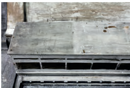
03 Model v průběhu restaurování – detailní pohled. Rozdíl mezi neočištěnou (vlevo) a očištěnou (vpravo) plochou střechy. Foto: Michal Polák.
