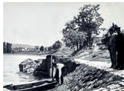
02 1925 – původní vodočet v Kamýku nad Vltavou. Zdroj: Archiv ČHMÚ.
