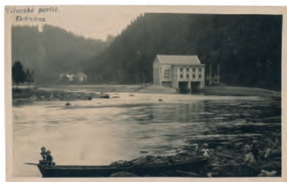
069 Letošnice – elektrárna / foto Plichta / 20. léta 20. stol. / archiv Vojtěcha Pavelčíka
