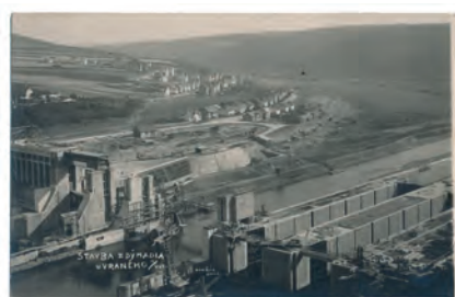
129 Stavba přehrady ve Vraném / Josef Dvořák / 1934 / archiv Vojtěcha Pavelčíka
