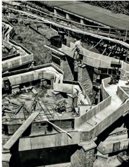
08 Stavba unikátního modelu celé Vltavské kaskády po jejím dokončení. Jedná se o komplexní model celé kaskády, který sloužil k modelování povodňových a průlomových vln, říční tratě, splavenin a hydrauliky podhrází či podjezí jednotlivých objektů. Tento výzkum je spojen s osobou prof. Dr. Ing. Pavla Nováka, DrSc., který výrazně přispěl ke zdokonalení teorie modelové podobnosti (Výzkumný ústav vodohospodářský T. G. Masaryka, 1962).
