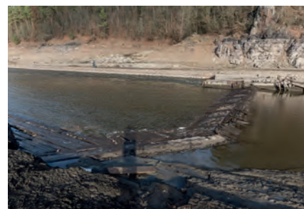
08 Zachovaný jez a vorová propust při pohledu z levého břehu Vltavy. Foto: Vojtěch Pavelčík (10. 12. 2019).
